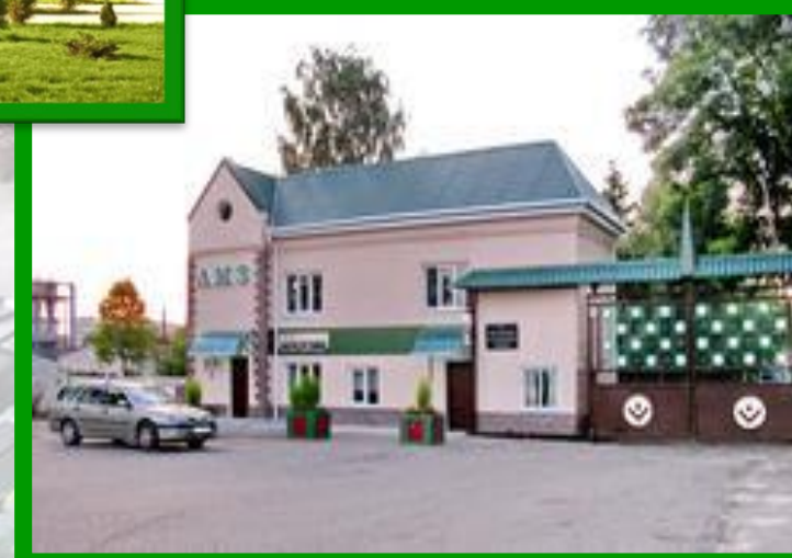
КУП «Сморгонский литейно-механический завод»
